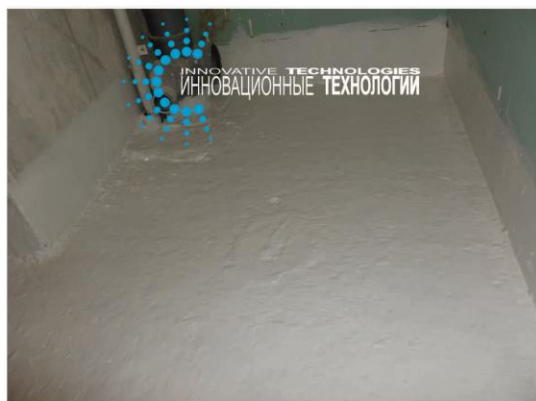
Готовая поверхность R-COMPOSIT
