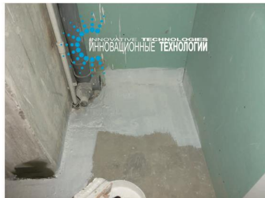
Нанесение грунта, приготовленного из покрытия R-COMPOSIT
