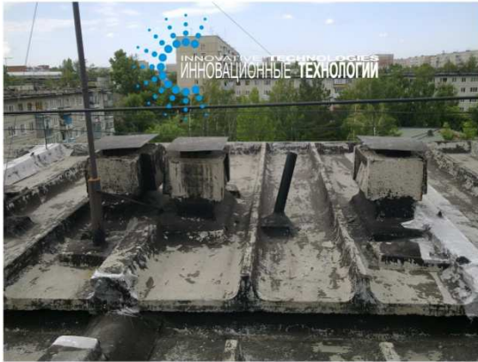
До выполнения работ
