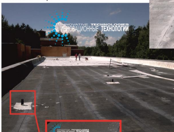
Армирование примыкания труб к плоскости кровли
