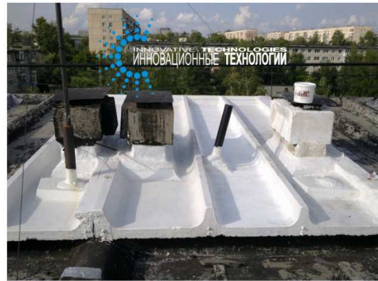
После выполнения работ
